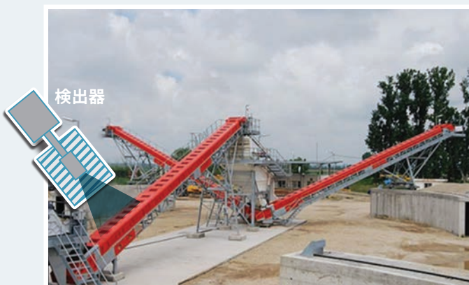
掘削土壌と破碎コンクリートの 核種別スクリーニングと分別
