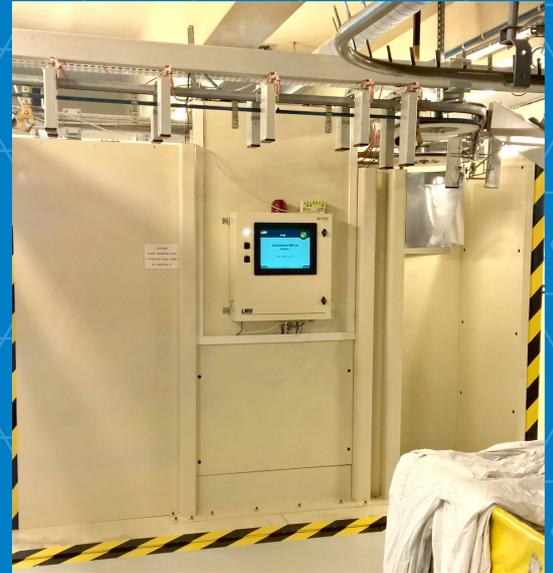
Le LMV-Smart est un contrôleur de linge vertical destiné à la vérification de la non contamination des tenues.
